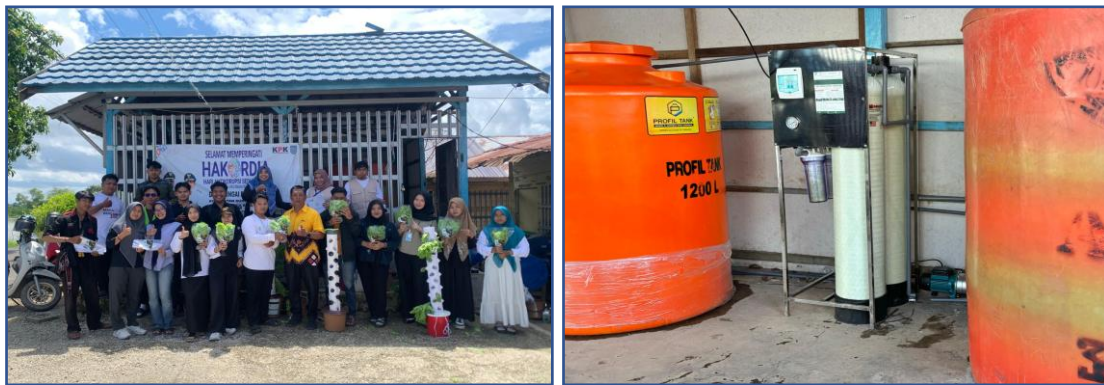
Gambar 1. Implementasi fasilitas pengolahan air bersih di Desa Sungai Bangkal: (a) rumah filtrasi sebagai lokasi pengelolaan sarana; (b) unit/instalasi ultrafiltrasi air bersih.
